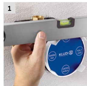
1 Zamocowanie elementu podtynkowego.
