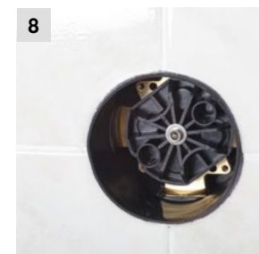
8 Demontaż modułu do przepłukiwania instalacji.
