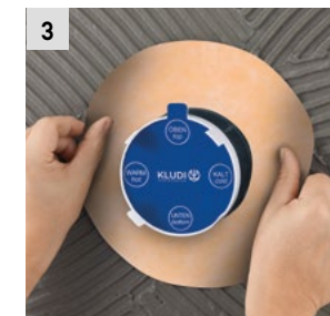
3 Położenie tynku i naklejenie kołnierza uszczelniającego.
