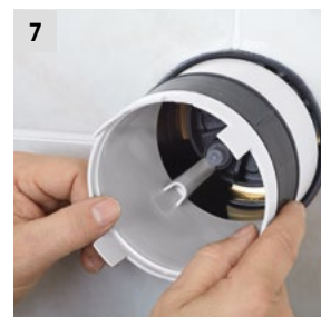
7 Wyciągnięcie elementu usztywniającego obudowę.
