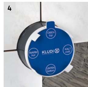
4 Przyklejenie płytek.
