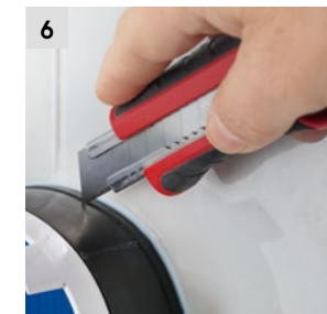
6 Odcięcie nadmiaru obudowy.
