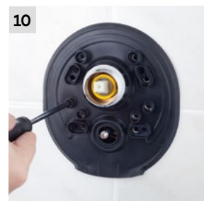
10 Montaż elementów zewnętrznych.
