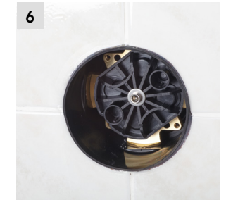
6 Demontaż modułu do przepłukiwania instalacji.
