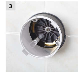
3 Przepłukanie instalacji.
