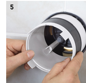
5 Wyciągnięcie elementu usztywniającego obudowę.
