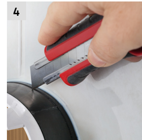
4 Odcięcie nadmiaru obudowy.
