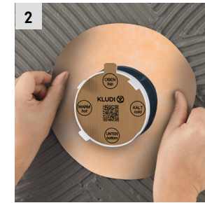
2 Położenie tynku i naklejenie kołnierza uszczelniającego.
