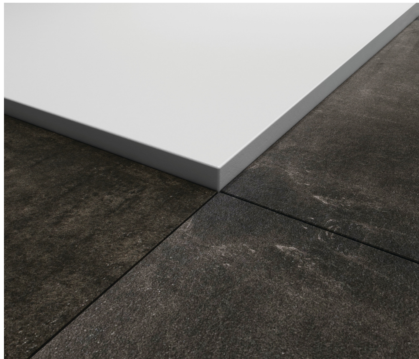
Częściowo wpuszczony w posadzkę
